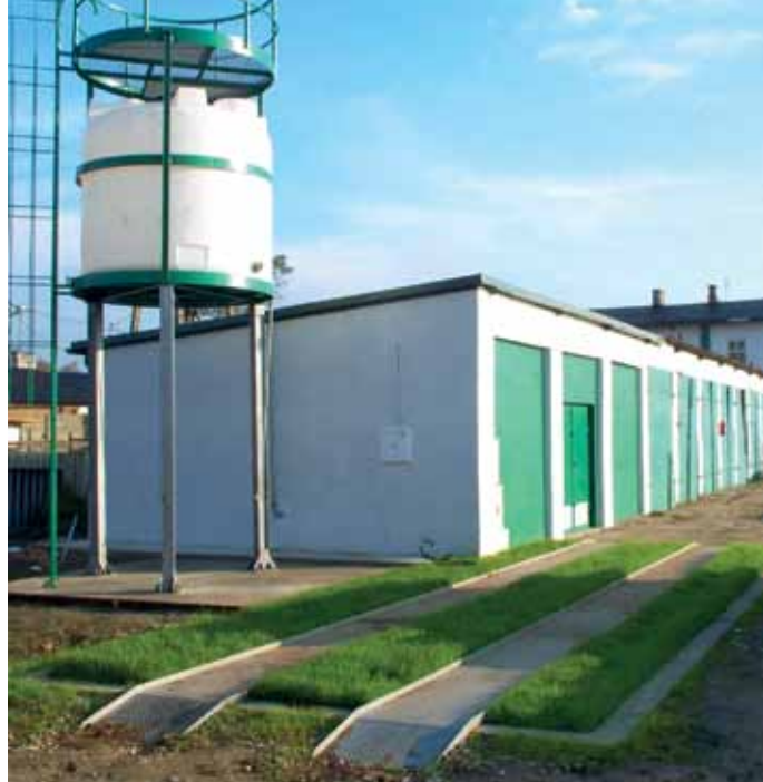
Fot. 2. Stanowisko Biobed obok stanowiska do napełniania opryskiwacza
